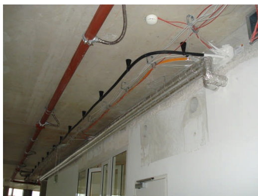
Beispiel einer Leckkabelschleife im Rohbau.
